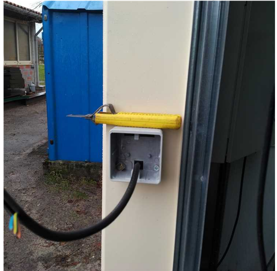
Mise en place du contacteur à clé extérieur
